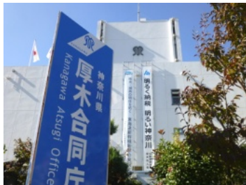
▲神奈川県厚木合同庁舎
